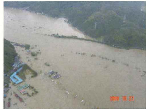
由良川 (H16.10.21 台風 23 号災害状況)
