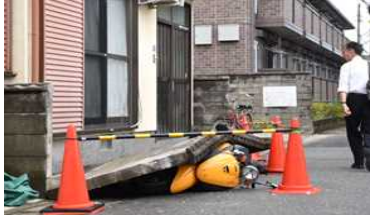
ブロック塀倒壊(長岡京市)
