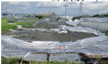
パイプハウス被害(八幡市)
