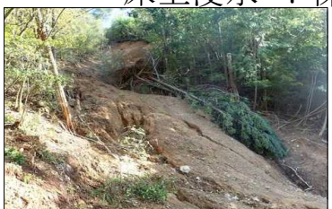
林地被害 (亀岡市)
