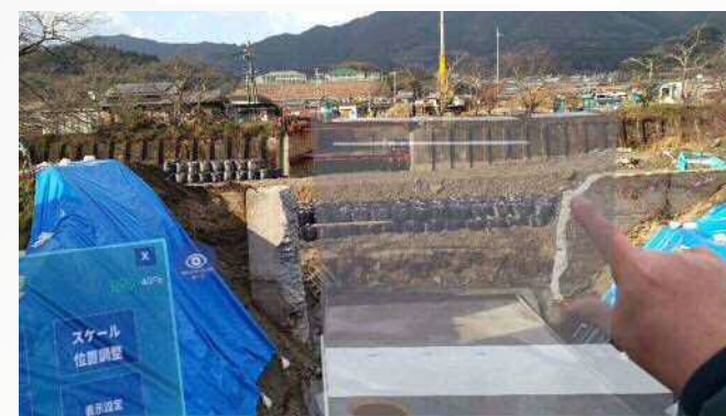
MRを活用した橋台位置の精度確認
