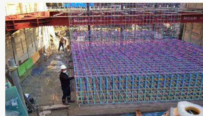
MRを活用した配筋の確認
