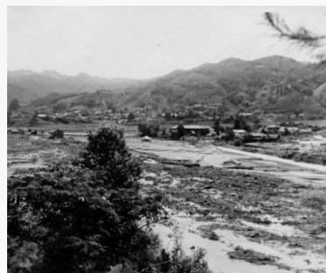
南山城水害状況 (昭和28年) ※中和東全景
