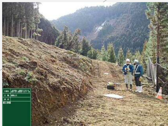
起工測量 (無人航空機)
