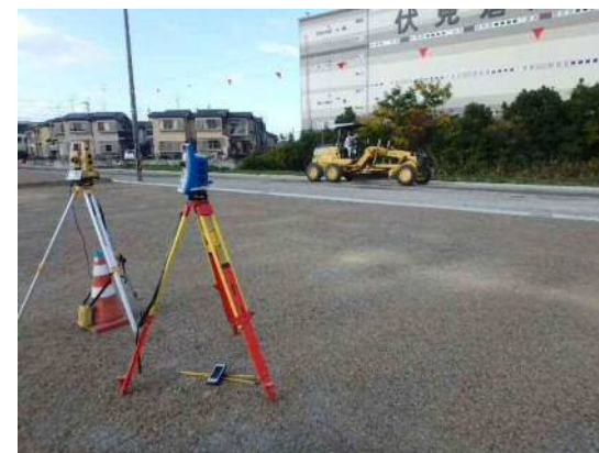
ICT建設機械施工 (3次元MCEータグレーダ)
