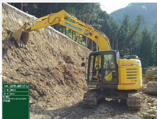
ICT建設機械施工 (3次元MGバックホウ)
