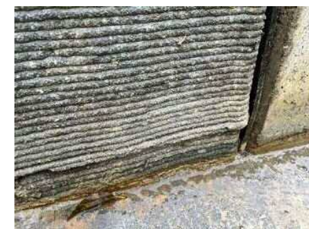
中空型枠での造形
