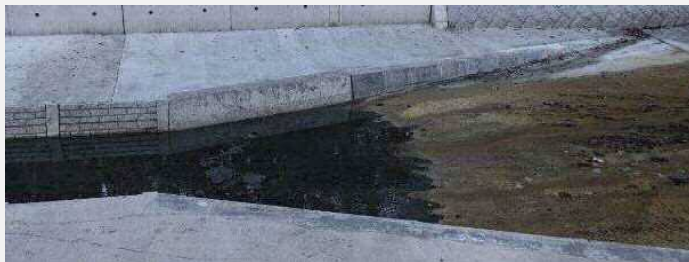
重力式擁壁施工における実証実験
