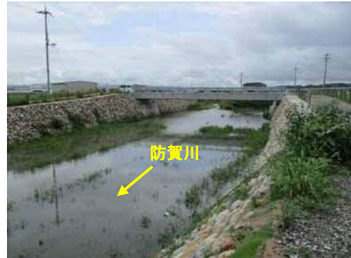
整備後 (虚空蔵谷川合流点付近)
