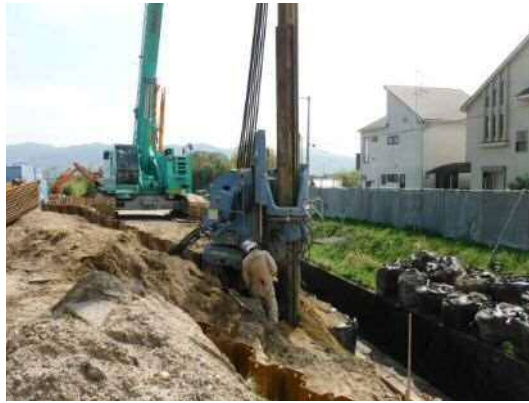
図- 344 近接家屋への騒音・振動対策の実施 (パイロガ-併用圧入工法)(防賀川)
