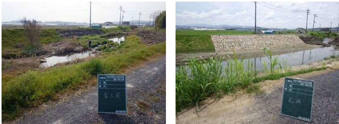
図- 333 多自然護岸整備の実施（左：施工前、右：施工後）（防賀川）
