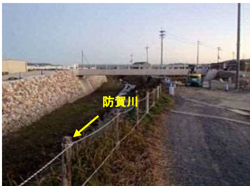
整備前 (虚空蔵谷川合流点付近)
