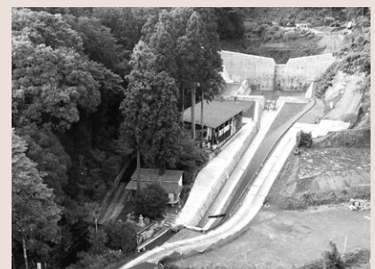
大鳥川砂防堰堤
