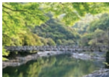
天ヶ瀬吊り橋
