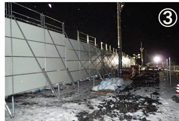
防音パネル(袖志側) (26. 12. 6設置)
