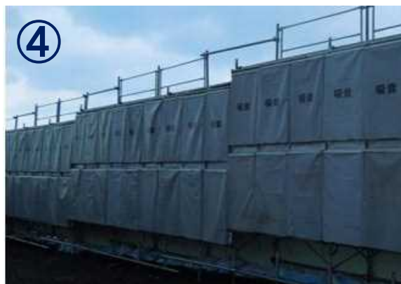
吸音パネル(③内面) (26. 12. 11設置)
