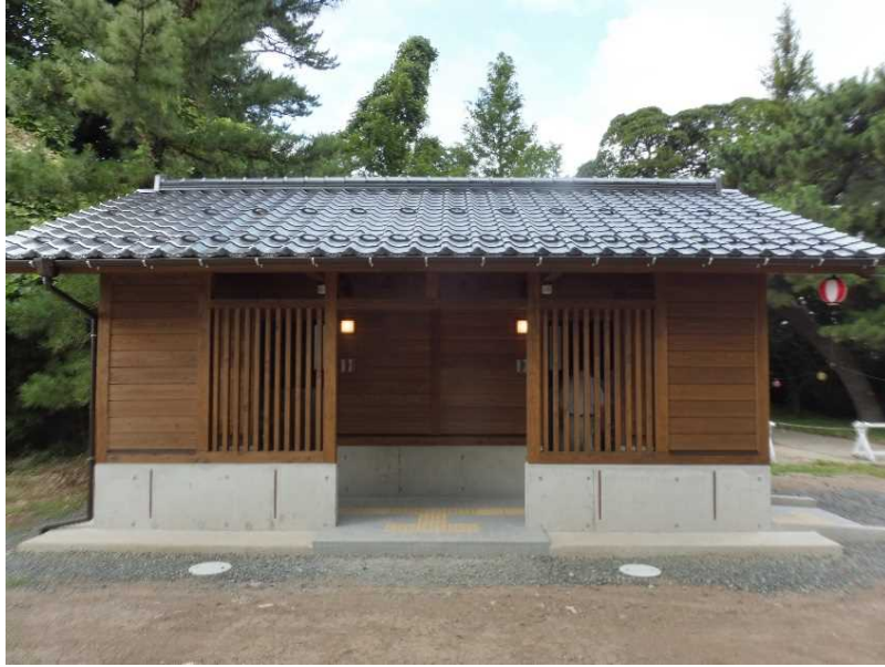
袖志観光トイレ整備事業 (丹後町袖志)
