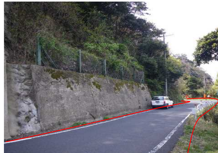
178号線(袖志工区)
