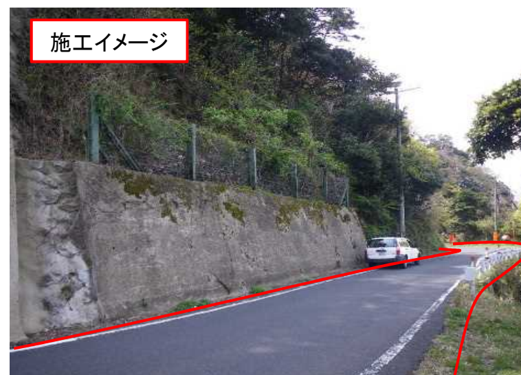
178号線(袖志工区)
