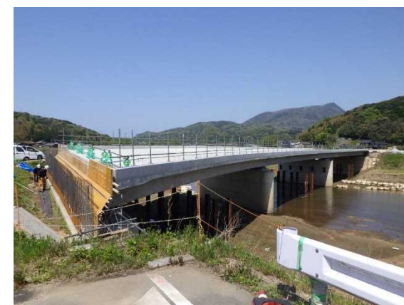
間人大宮線(大門橋右岸から撮影)
