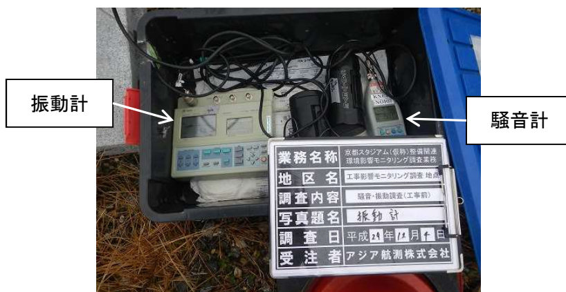
写真 2-1-3 騒音振動調査（工事影響モニタリング調査）騒音計・振動計の設置状況
