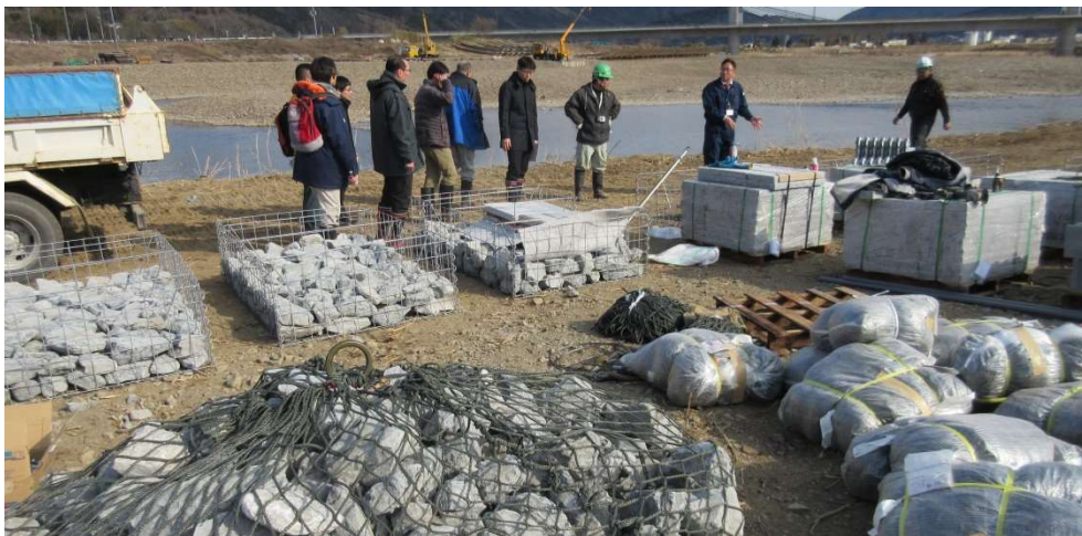
写真 3-2-1 H30. 2. 22 工事指導状況
