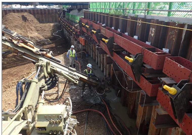
《グラウンドアンカー施工状況》
