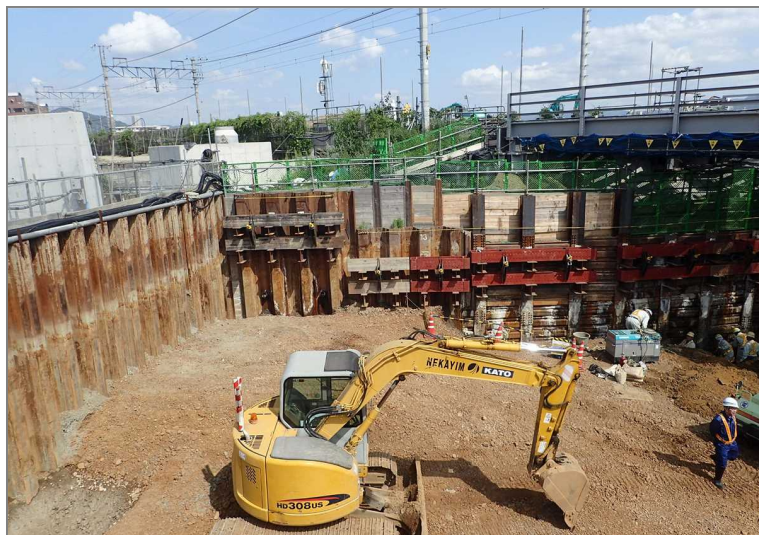
《グラウンドアンカー完成状況》
