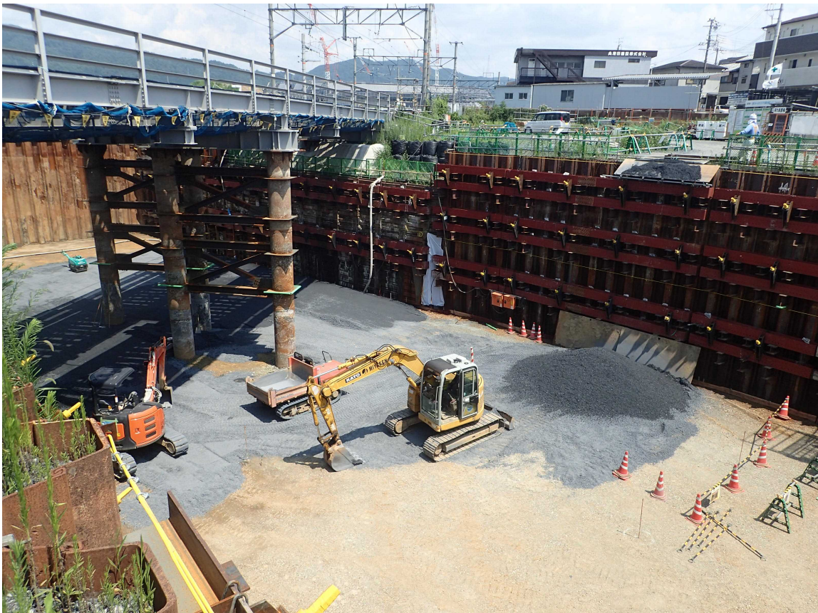
写 2-4-1 掘削床付けが完了し、基礎碎石施工中の状況写真
