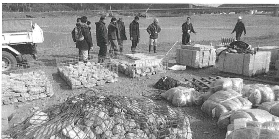
写真 3-2-1 H30. 2. 22 工事指導状況
