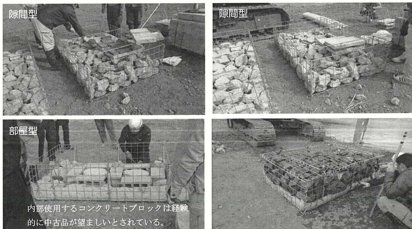
図 3-2-4 H29 年度設置の改良カゴマット（2018. 2. 22 撮影）
