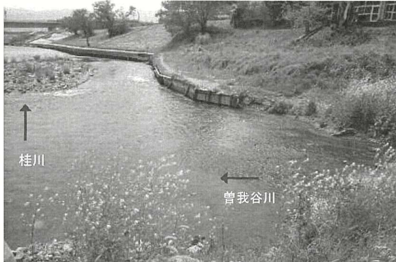
【写3-1-12 放流地点下流(図3-1-7中①)】
