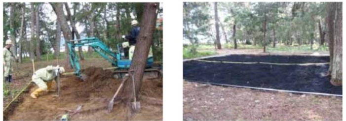
腐植土除去の試験実施状況
