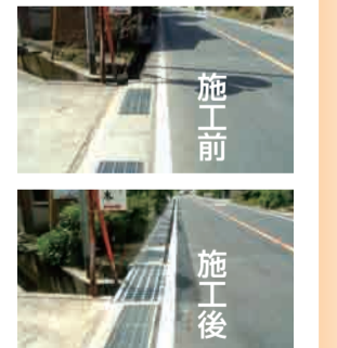
通行の安全確保のため、側溝にふたを設置
