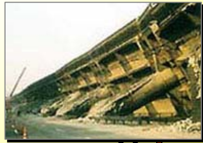
阪神・淡路大震災での被害状況（神戸市）
