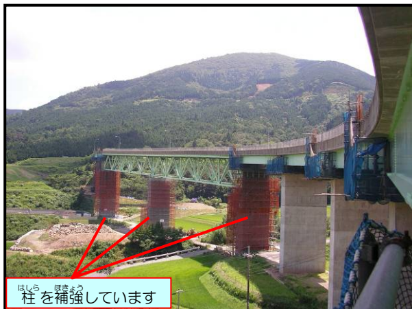
柱の補強工事
