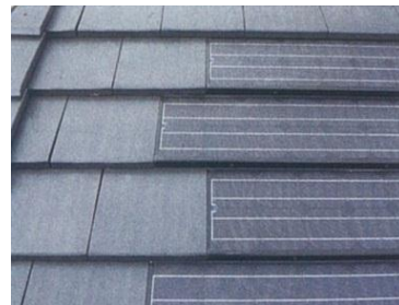
屋根材を兼ねた太陽光パネル設置
