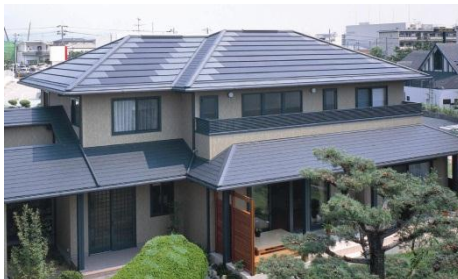
屋根材を兼ねた太陽光パネル設置
