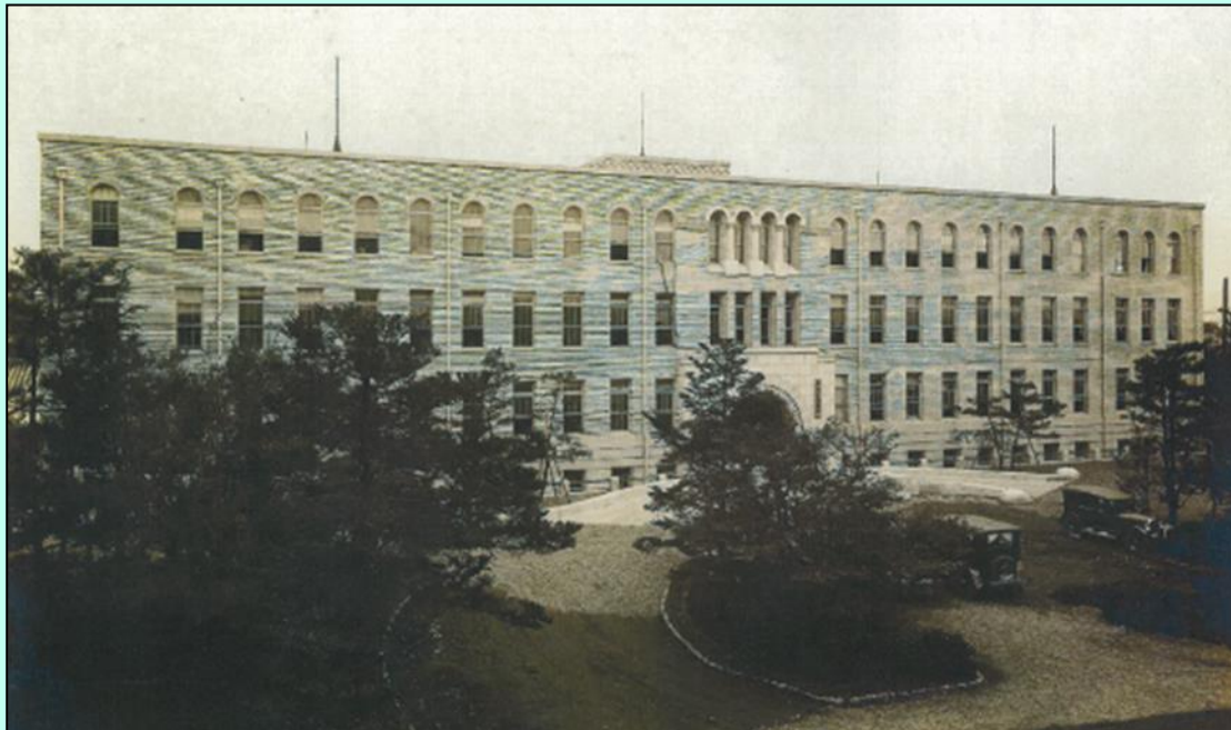
【建設(昭和2年3月)当時の府警本部本館】
